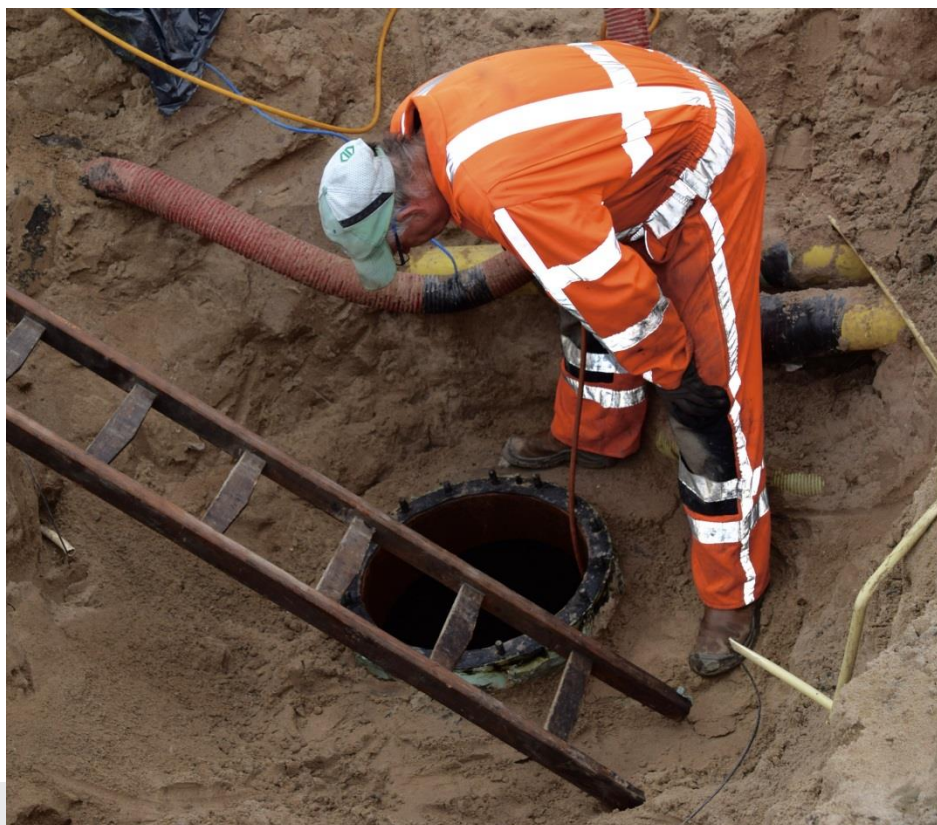
Foto: Mangat tank
